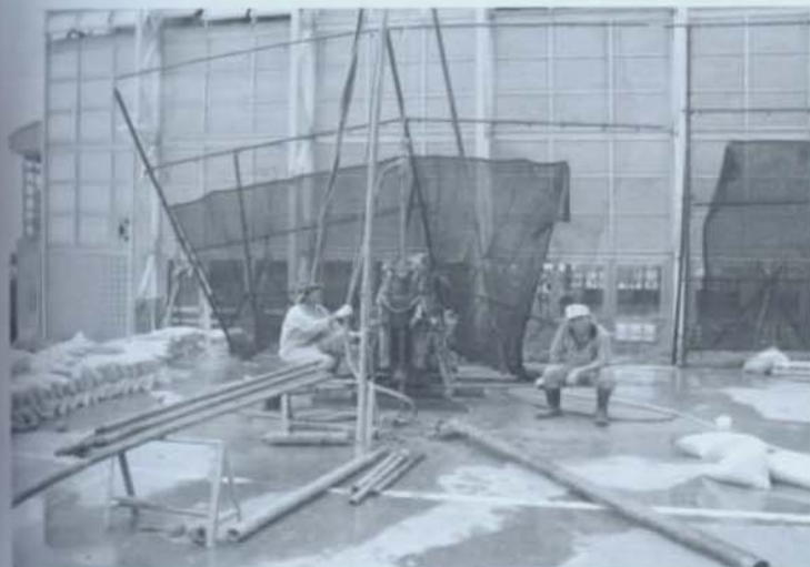
工程人員進行鑽探
