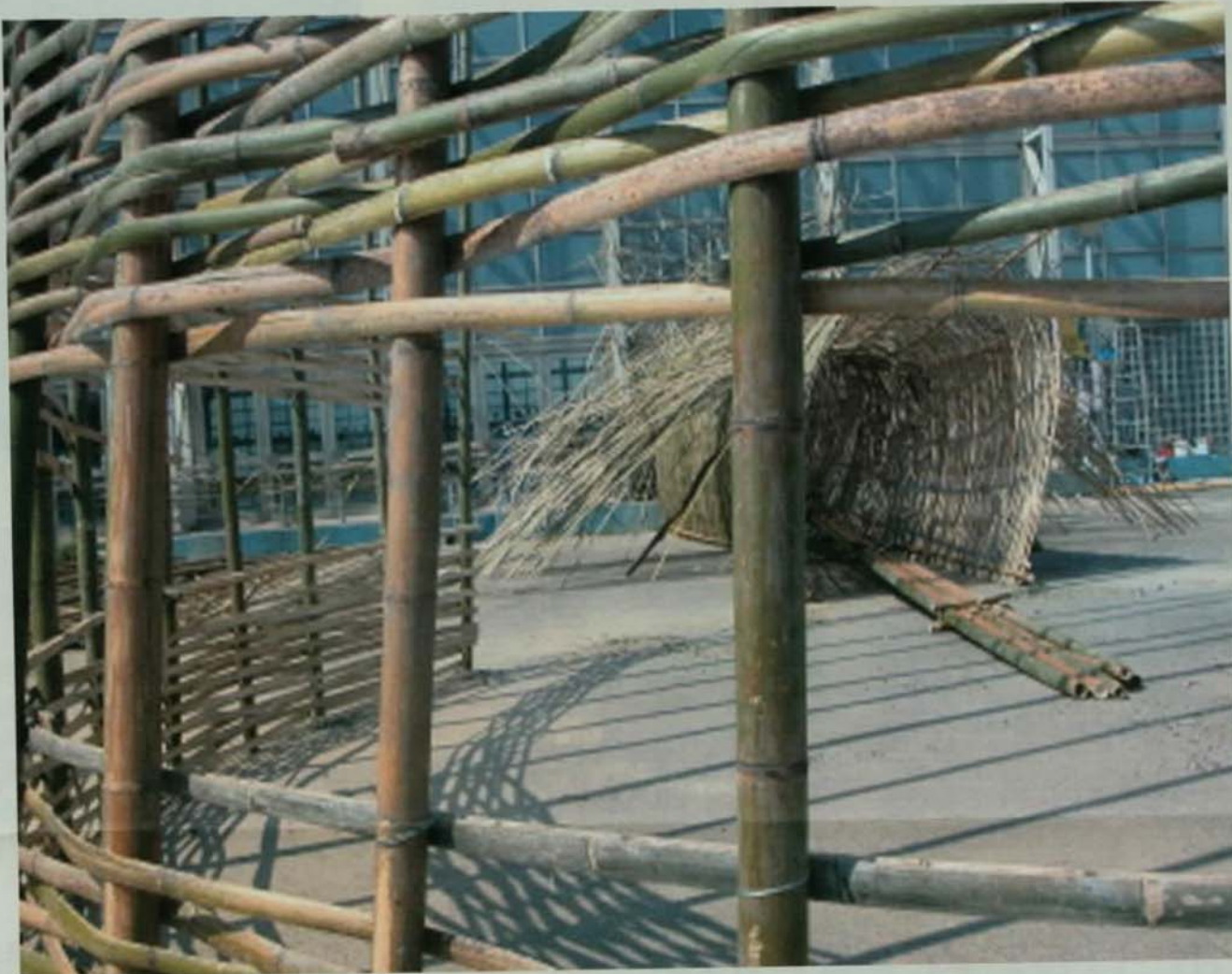
▲施工中的九二九劇場。
